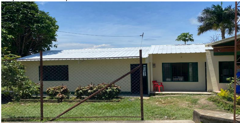
Bloque aulas Cubierta y Pintura
