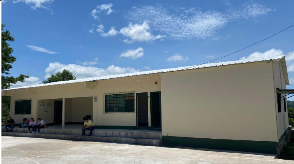
Bloque aulas Cubierta y Pintura
